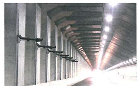
Installation des PEC Kabelhaltersystems im Tunnel
